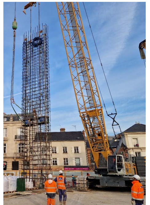
Tek seviye O-Cell ile donatılmış çelik donatı kafesinin yerleştirilmesi
